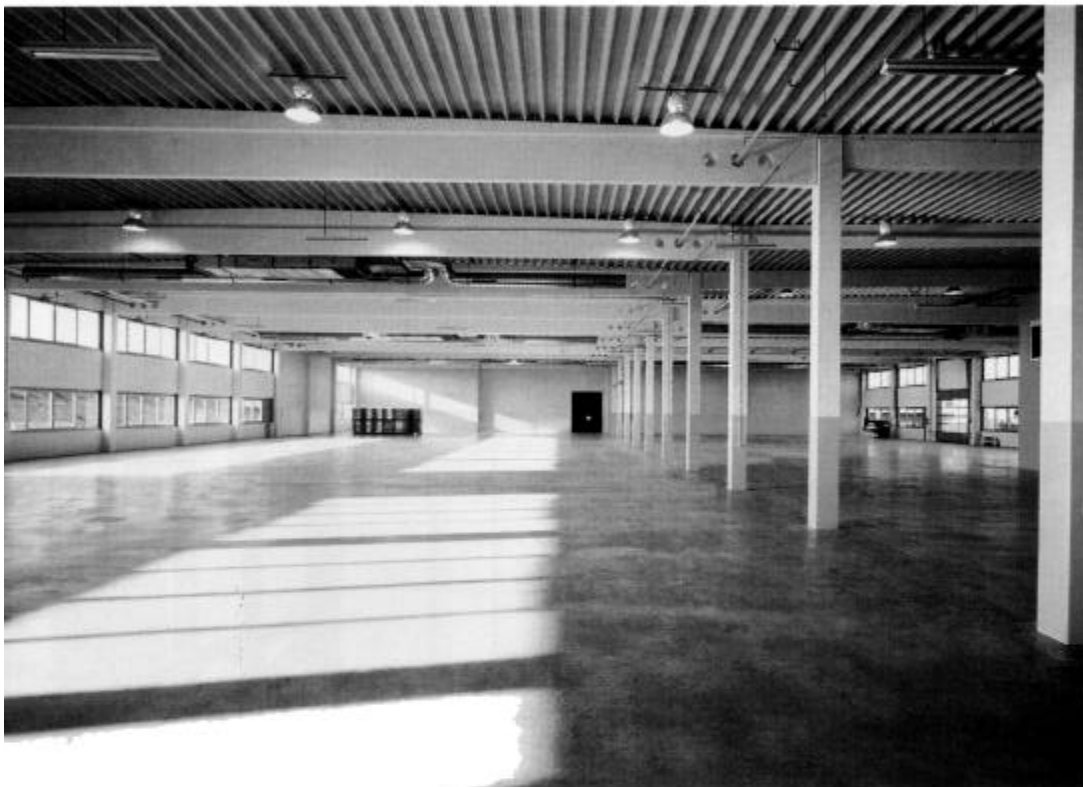
Der Fußboden in dieser Lager- und Produktionshalle von Hewlett-Packard hat eine Fläche von 30.000 m 2 und ist nach dem CCF System hergestellt worden.
